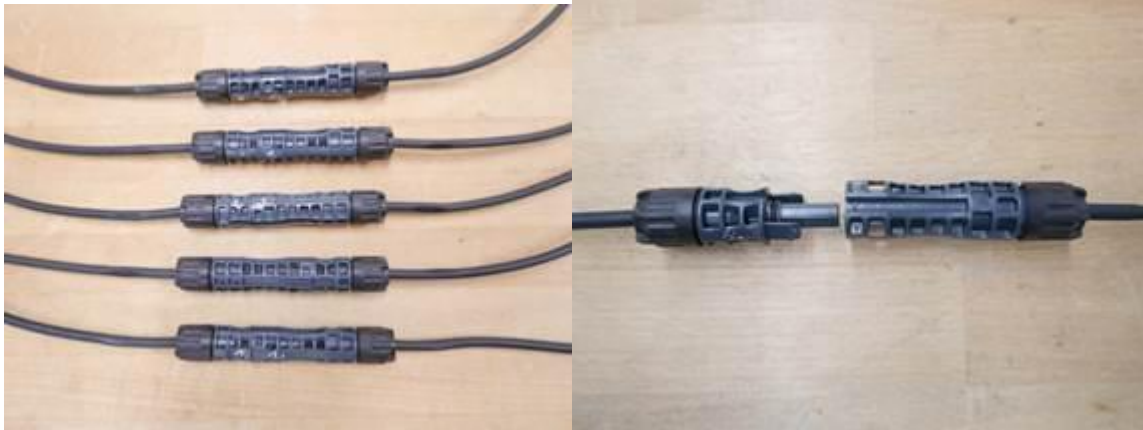
Abbildung 20: Prüfmuster #2 nach 830 T-Zyklen (links) und nach Dielectric Strength Test geöffnet (rechts).
